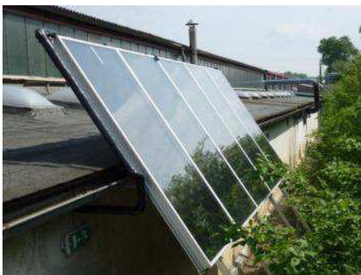
Abbildung 5-8: Kollektorfeld mit Sensoren T1, rad
