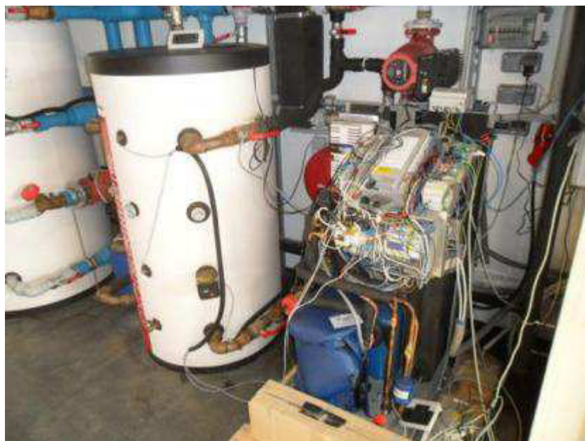
Abbildung 5-4: Wärmepumpe mit Pufferspeicher
