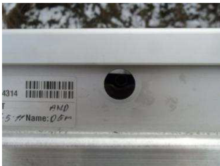
Abbildung 5-10: Position Absorbertemperaturfühler
