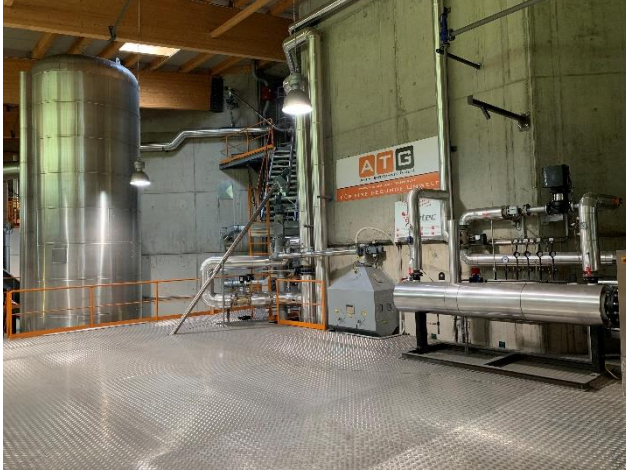
Bild links: die Fertig installierte Power-to-Heat Anlage und Bild rechts: der installierte 63.000 Liter Pufferspeicher
