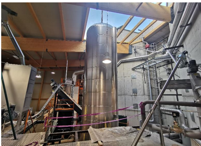
Fotos vom Einbau des 63.000 Liter Pufferspeichers ins Nahwärmeheizwerk Murau-Stolzalpe
