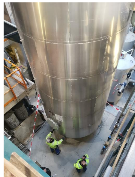
Fotos vom Einbau des 63.000 Liter Pufferspeichers ins Nahwärmeheizwerk Murau-Stolzalpe
