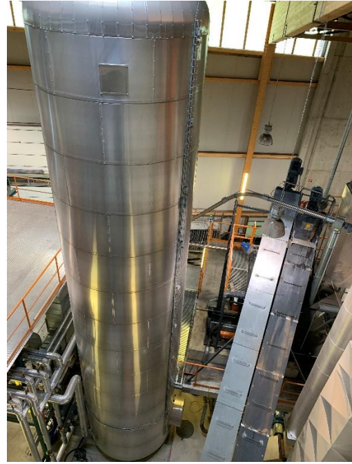
Bild links: die Fertig installierte Power-to-Heat Anlage und Bild rechts: der installierte 63.000 Liter Pufferspeicher
