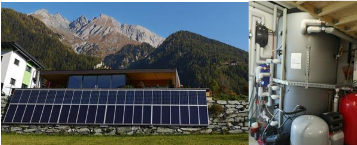
Abbildung 1: Südansicht und Technikraum des Solarhauses Felsch (Quelle: Bauherr)
