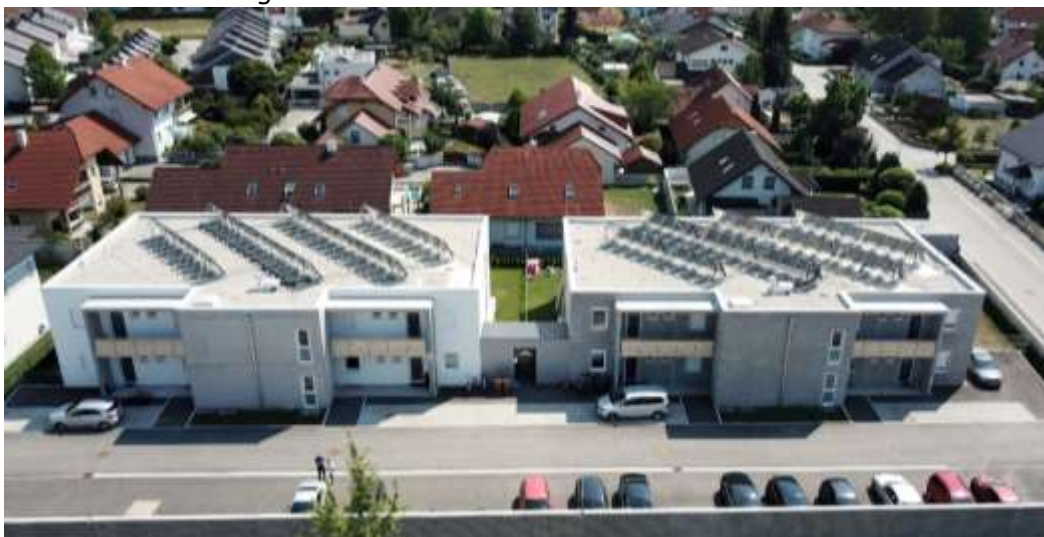
Abbildung 1: Luftbild der Betriebsgebäude inkl. Solaranlage (Quelle: Franz Oberndorfer GmbH)
