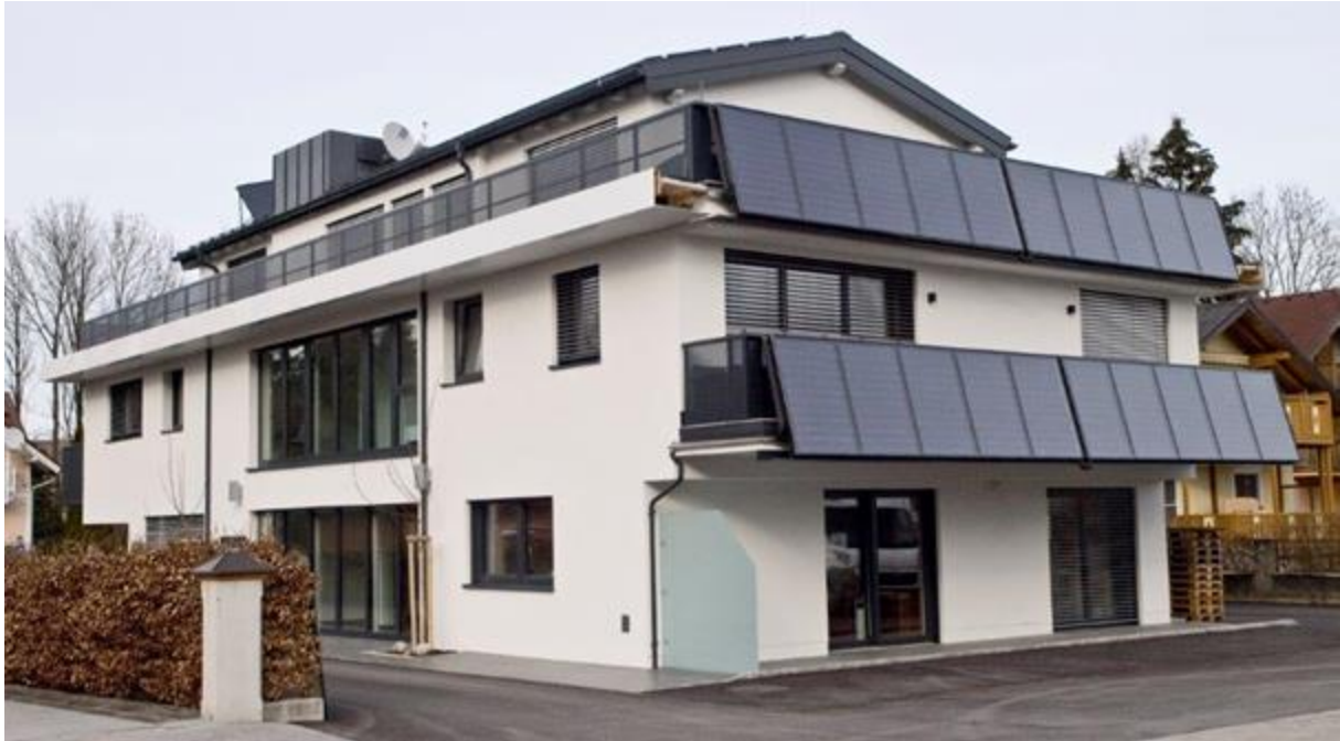
Abbildung 1: Ansicht des Neubaus ALWI Solarbüro (Quelle: FIN - Future is Now GmbH)
