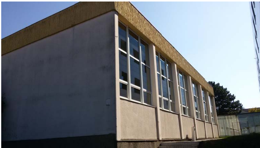
Abbildung 1: Turnsaal westliche Ansicht:
