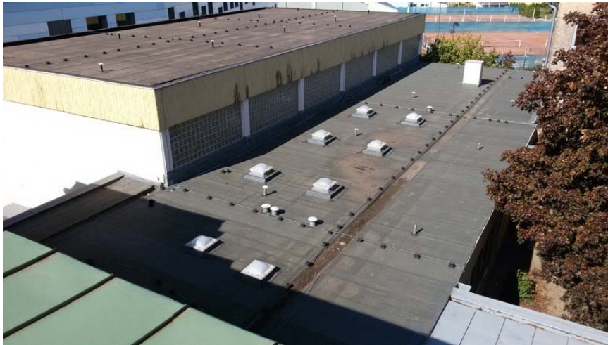
Abbildung 3: Dachdraufsicht Turnsaal und Umkleidebereich
