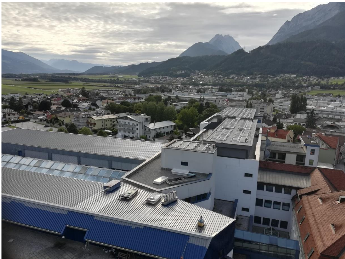
Bild2: Fertiggestellte PV-Anlage BA1+2 © BKH-Schwaz
