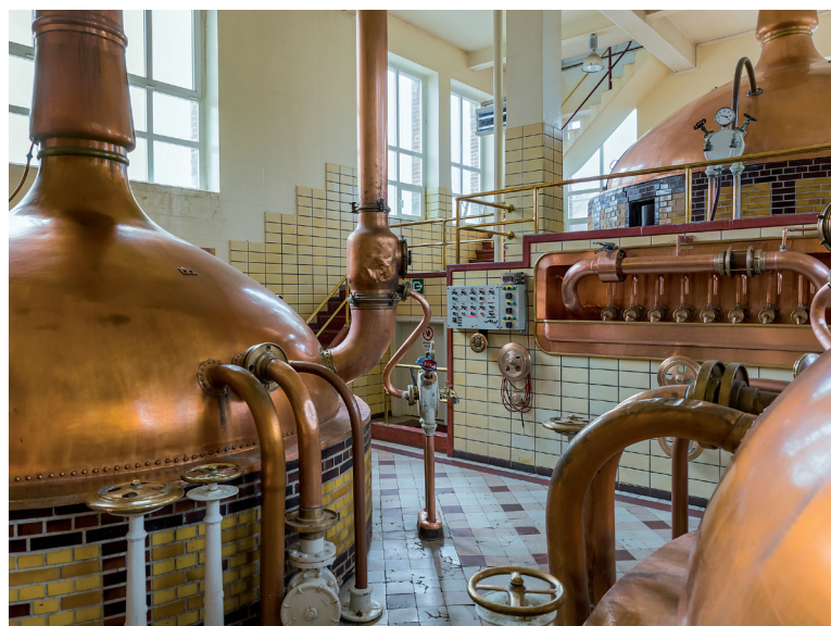
Der Strom der zum Bierbrauen benötigt wird, soll schon bald mit Hilfe von Photovoltaik Anlagen erzeugt werden.
