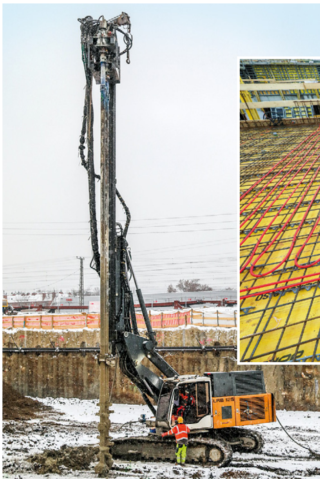
Unter dem Neubau in der Käthe-Dorsch-Gasse wurden 60 Tiefenbohrungen in 140 Metern Tiefe ausgeführt (links). Die Bauteilaktivierung in den Geschößdecken wird als Niedertemperatur-Flächenheizungen und -kühlungen eingesetzt (rechts).
