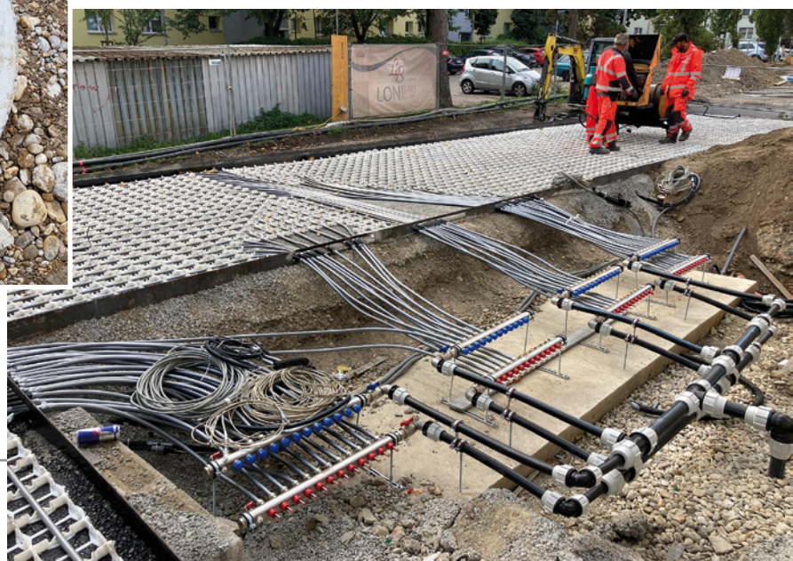
Die Asphaltkollektoren werden eingesetzt um überschüssige Sonnenwärme vom Asphalt zu gewinnen. Diese Asphaltkollektoren nehmen im Sommer die Wärme des Bodenbelages auf, welche dann im Winter zum Heizen verwendet werden kann.
