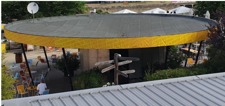
Abb. 3: Holz-, Strahlkonstruktion mit Bitumendach
