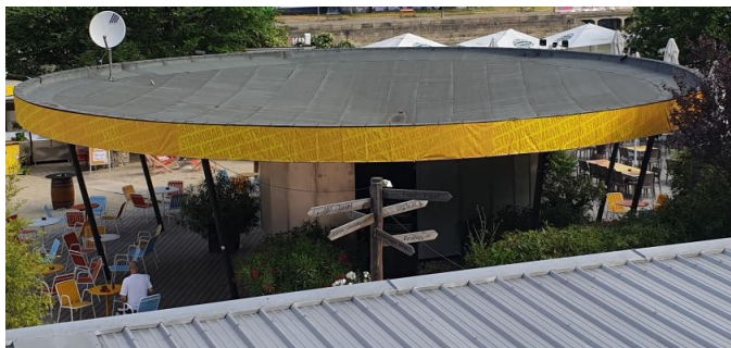
Abb. 1: Holz-, Stahlkonstruktion mit Bitumendach
