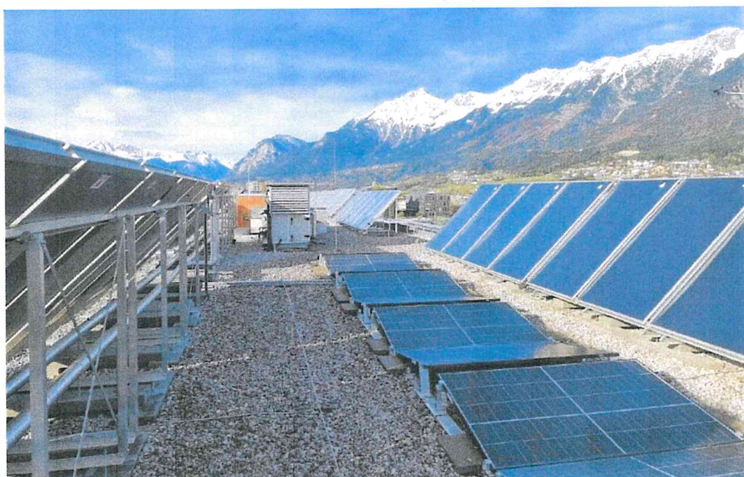
Abb.: 3 Solaranlage nach Fertigstellung
