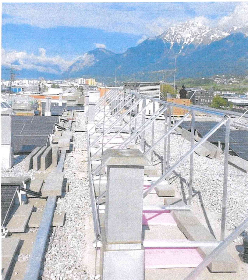
Abb.: 2 Solaranlage in der Bauphase
