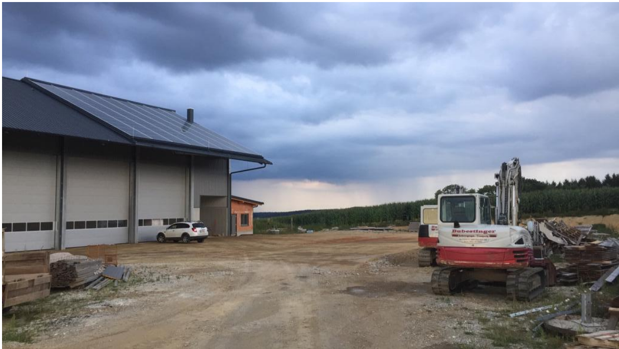
Abbildung 3: Kollektoranlage am Dach der Trocknungshalle (Quelle: T. Dachs)
