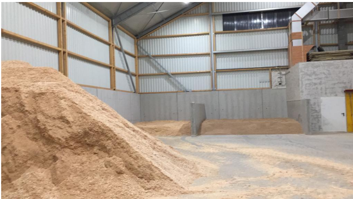
Abbildung 4: Innenraum der Trocknungshalle. Im Hintergrund die beiden Trocknungsroste sowie die Solarleitungen (Quelle: T. Dachs)
