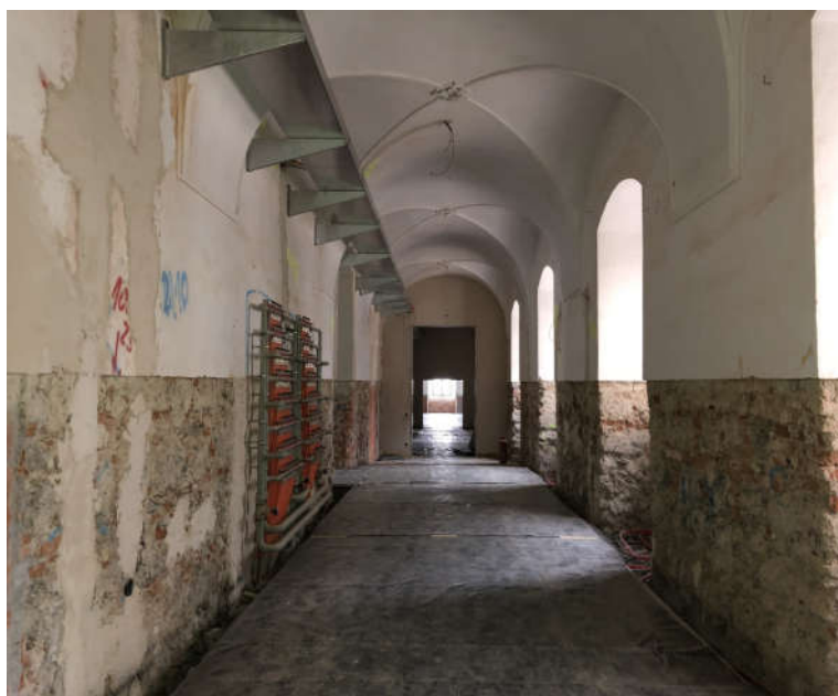
Abb. 01: Fertigstellung der bauteilaktivierten Stahlbetonplatte = FB im EG
