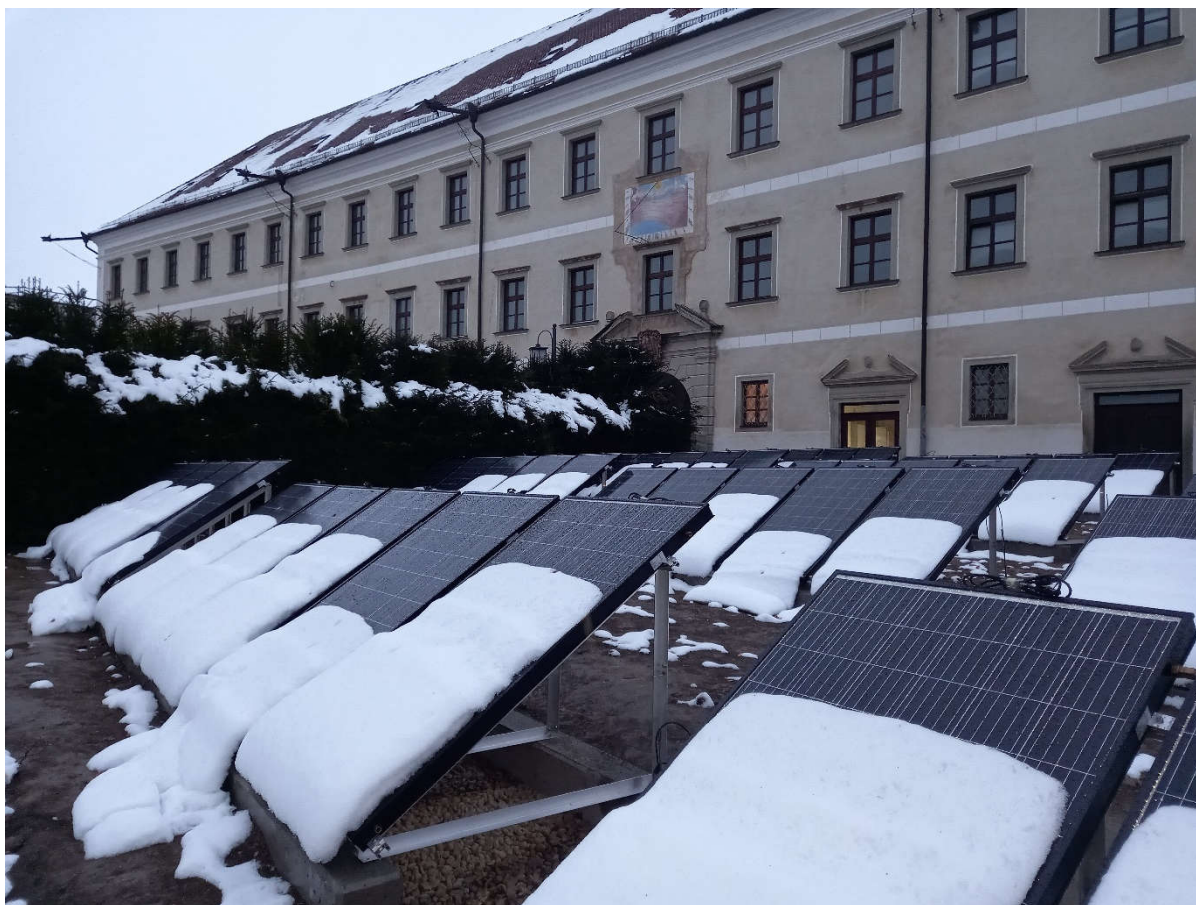
Abb. 04: Montage der Hybridkollektoren im Garten neben dem Stiftsgebäude
