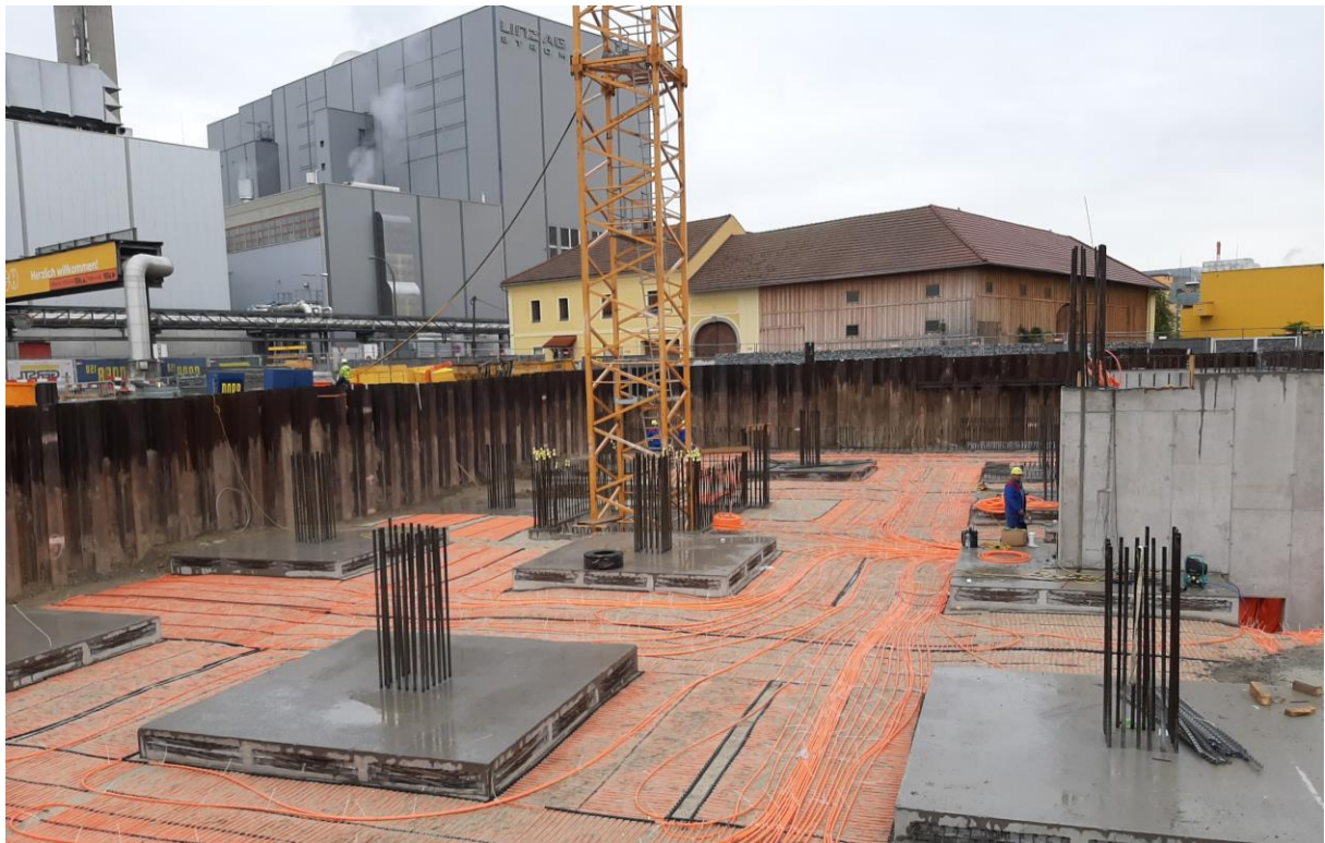
Abbildung 2 Verlegung des Erdspeichers
