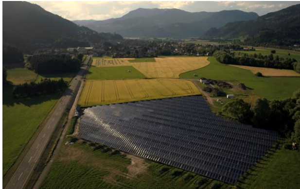
Abbildung 2: Kollektorfeld kurz nach Fertigstellung
