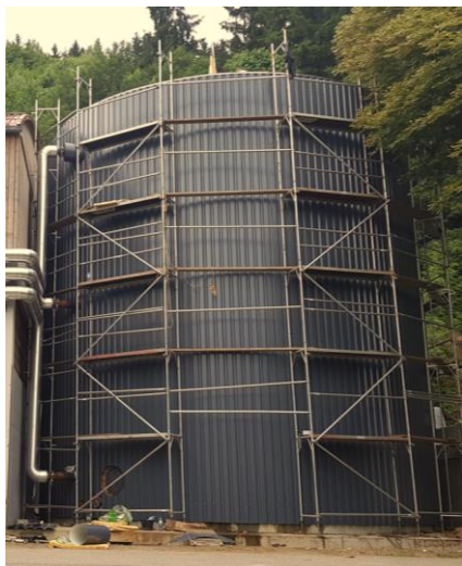
Abbildung 6: Isolierarbeiten am Wärmespeicher
