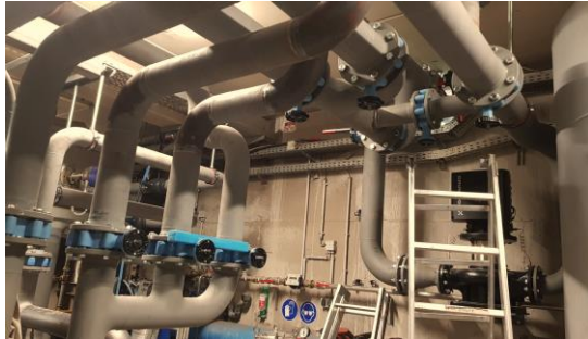
Abbildung 5: Installation der Wärmeübergabestation im Heizhaus
