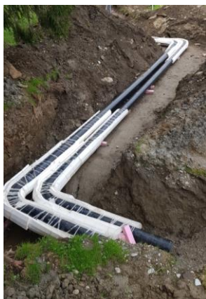
Abbildung 4: Verlegung der Transferleitung
