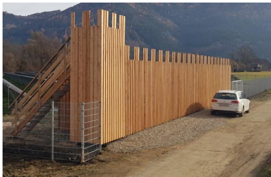
Abbildung 3: Container der Solarübergabestation
