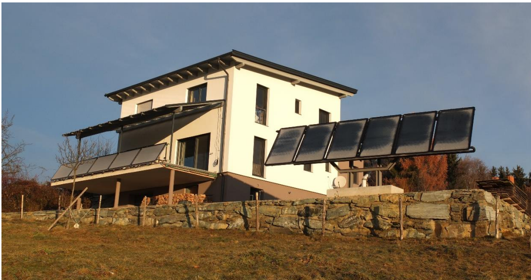
Abbildung 1: Südansicht des Solarhauses Inschlag (Quelle: Bauherr)
