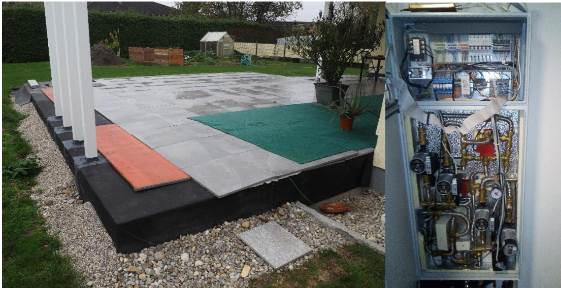
Abbildung 2: Terrasse über Saisonspeicher (links), Hydraulik (rechts) (Quelle: AEE INTEC)
