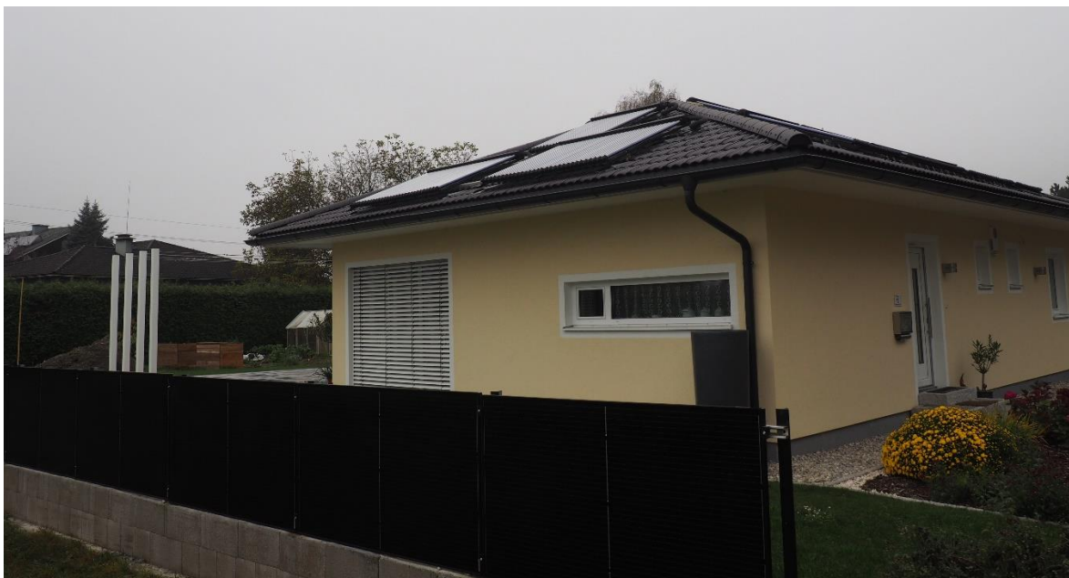
Abbildung 1: Südansicht des Solarhaus Dicklhuber (Quelle: AEE INTEC)
