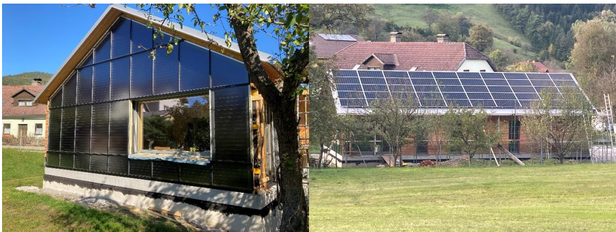
Abbildung 1: Südwestansicht des Solarhauses Anzberger inkl. Solarthermieanlage (links), Südostansicht inkl. PV-Anlage (rechts) (Quelle: Bauherr)
