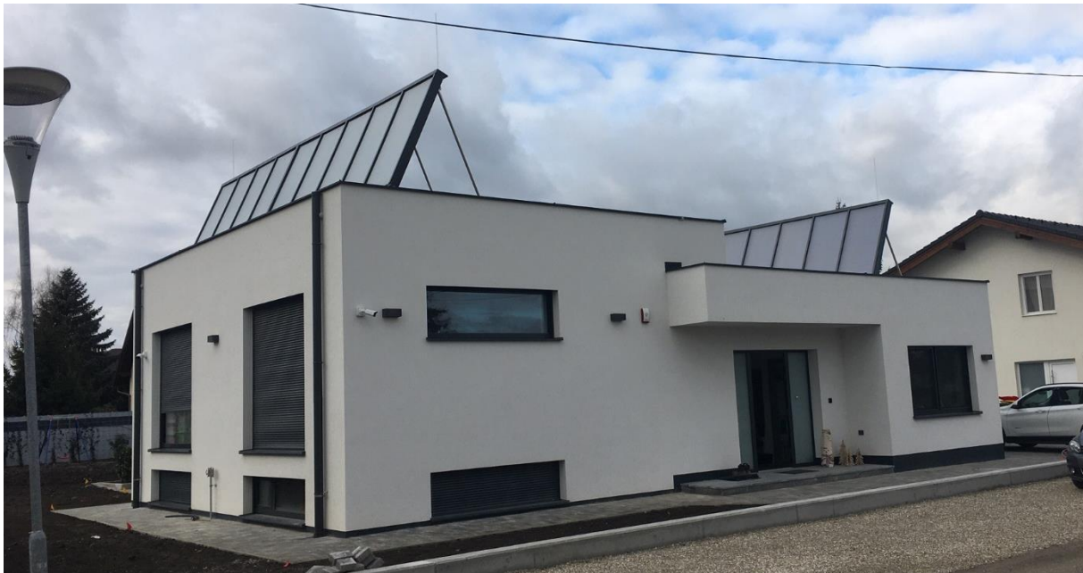
Abbildung 4: Ost-Ansicht des Solarhauses Ammerer (Quelle: Bauherr)
