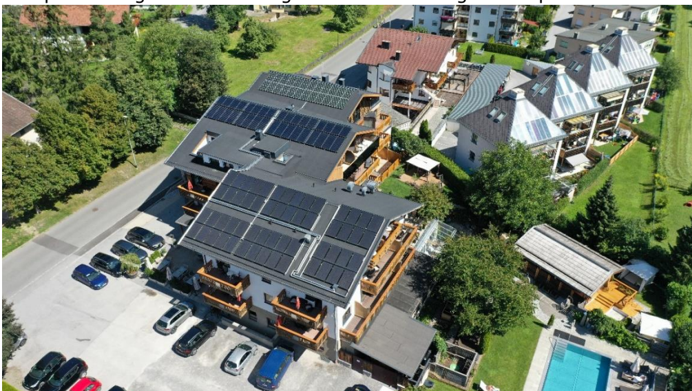
Abbildung 1: Luftbild von Hotel Riederhof, PVT Kollektoren, Solarthermie Flachkollektoren, PV-Anlage (von unten nach oben) (Quelle: 3F-Solar)
