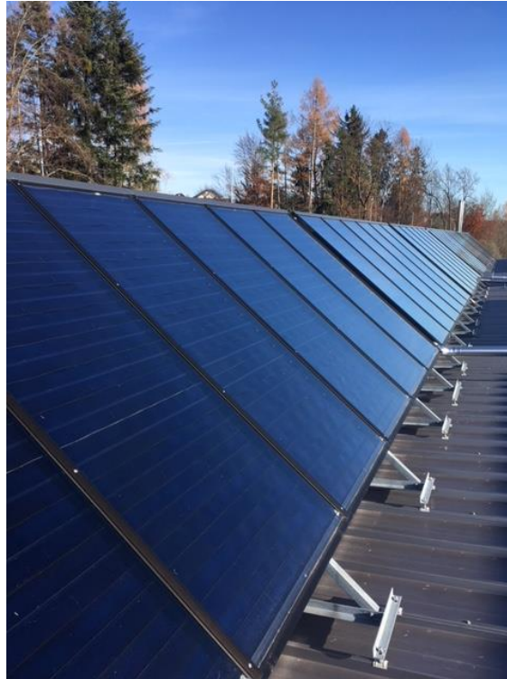
Abbildung 1: Seitenansicht Gebäude samt Kollektoren der Anlage Weizer Schafbauern (Quelle: Betreiber).
