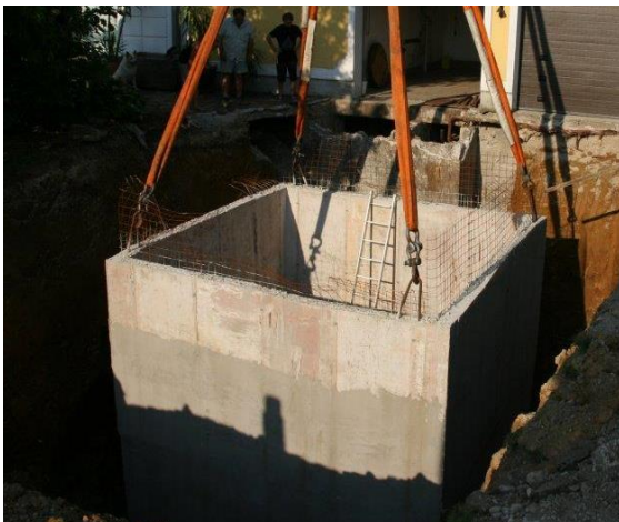
Abbildung 2: Darstellung des 30 m 3 Pufferspeicher während der Errichtung auf dem Betriebsgelände des landwirtschaftlichen Betriebs Schickmaier (Quelle: Schickmaier).
