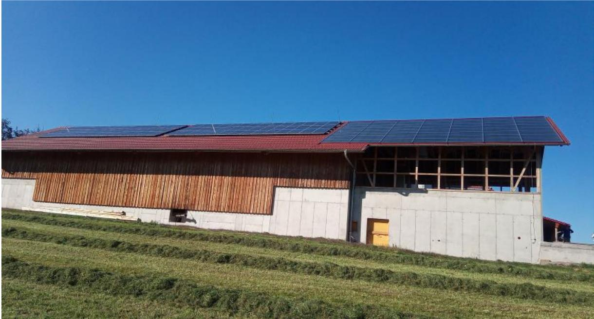
Abbildung 1: Luftkollektoranlage (rechts) und 30 kWp Photovoltaik-Anlage (links) auf dem Dach der Trocknungshalle (Quelle: AEE INTEC)
