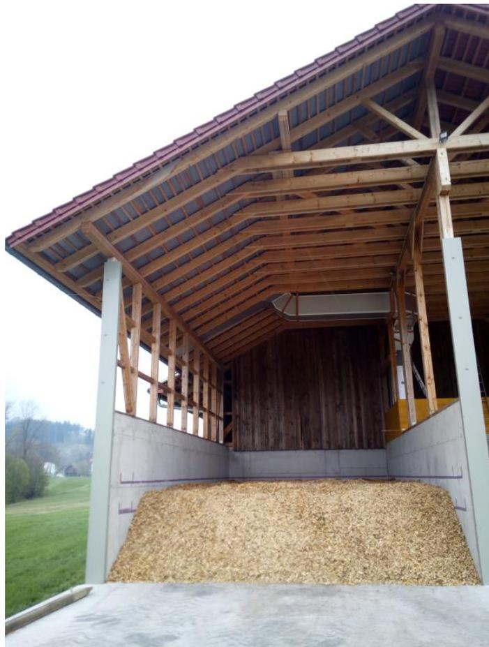
Abbildung 2: Solarleitung vom Dach zu Steinspeicher bzw. Mischkammer der Hackguttrocknung Mader (Quelle: AEE INTEC)
