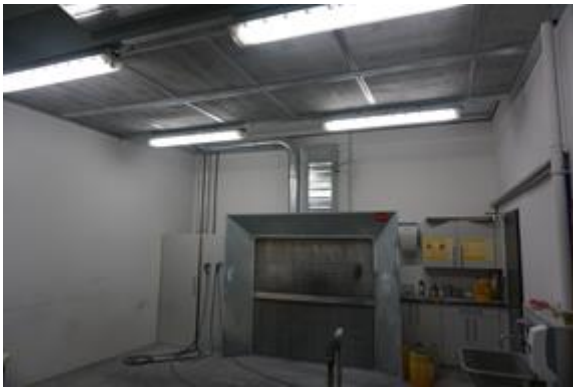
Abbildung 2: Lackierraum (links) und Lüftungsanlage (rechts) über welche der Lackierraum konditioniert wird (Bildquelle: AEE INTEC)
