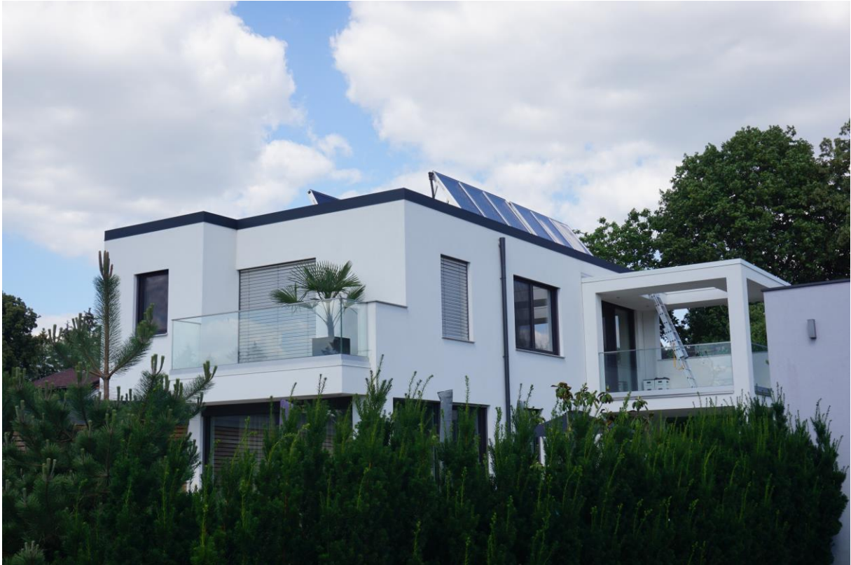
Abbildung 1: Westansicht des Solarhauses Fasching (Quelle: AEE INTEC)
