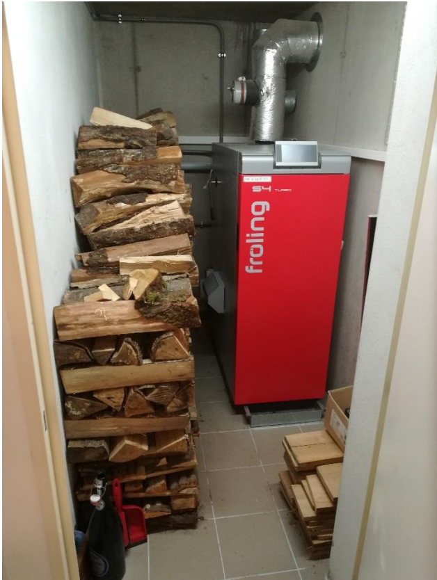
Abbildung 4: Manuell beschickter 30 kW Scheitholzkessel (Quelle: AIT)
