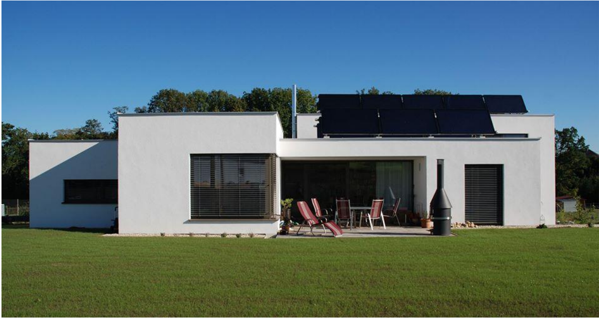
Abbildung 1: Südwest-Ansicht des Gebäudes mit Solarthermie-Kollektoren (oben), (Quelle: Fördernehmer)
