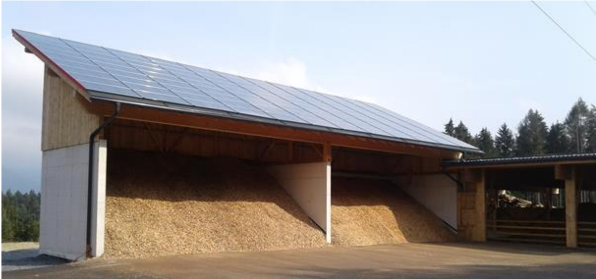
Abbildung 2: Südansicht der Trocknungsanlage der Regionalenergie Natters eGen (Quelle: Bauherr)
