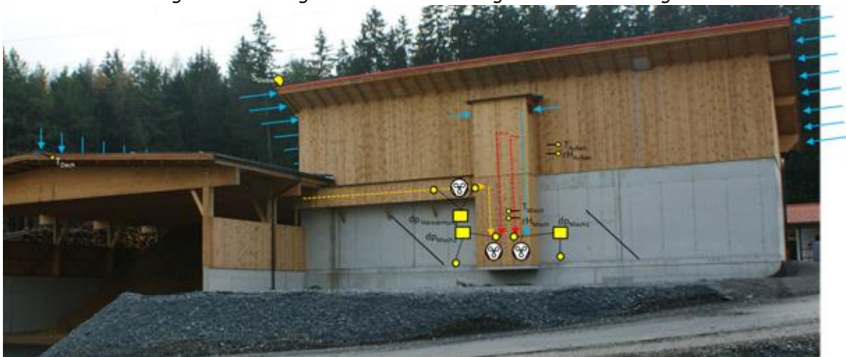
Abbildung 4: Schematische Darstellung der Luftführung anhand der realen Anlage (Bildquelle: AEE INTEC)
