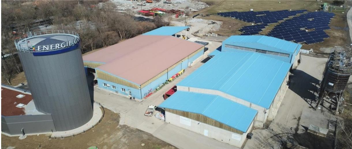
Abbildung 1: Ansicht des Speicherprojekts HELIOS der Energie Graz – Heizzentrale mit 2.500 m<sup>2</sup> Pufferspeicher, Kollektorfeld in erster Ausbaustufe (2.000 von 10.000 m<sup>2</sup>) (Quelle: Energie Graz)
