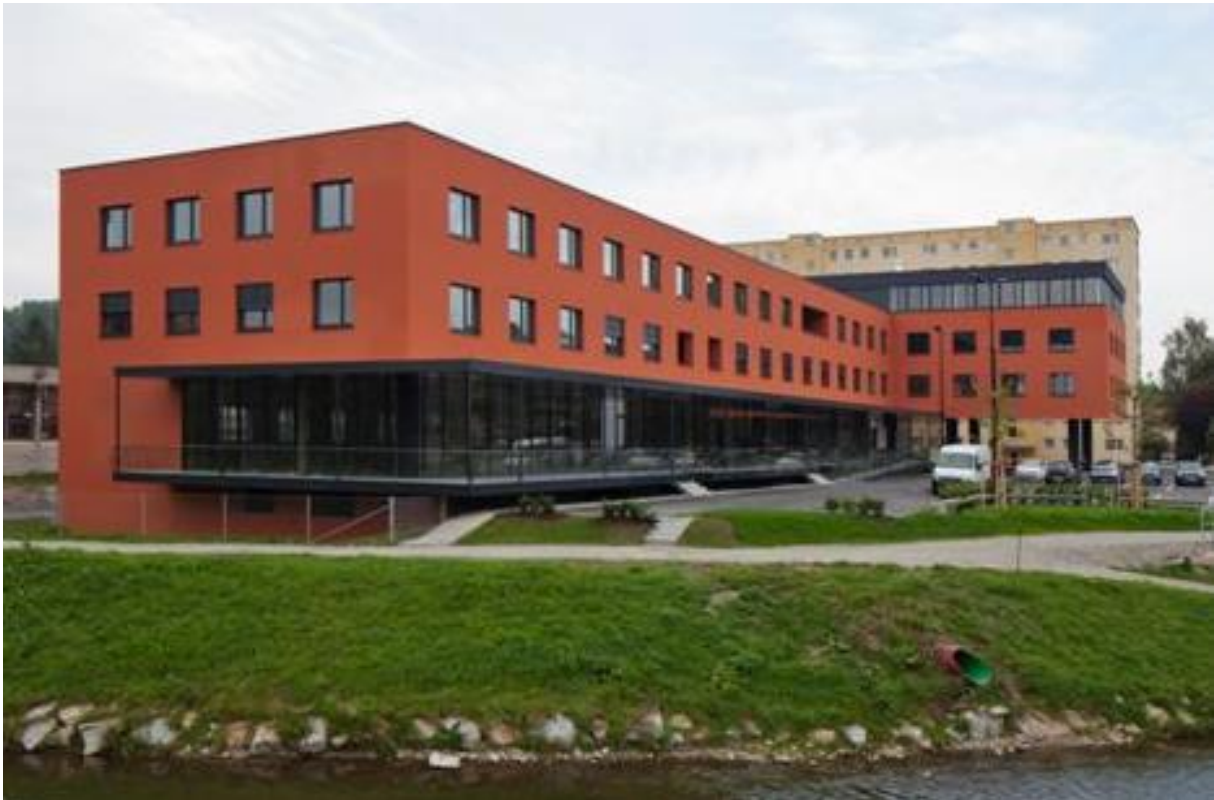
Abbildung 1: Südwestansicht des DLZ Grieskirchen. Quelle: WAIZENAUER BAUUNTERNEHMEN GMBH & CO KG
