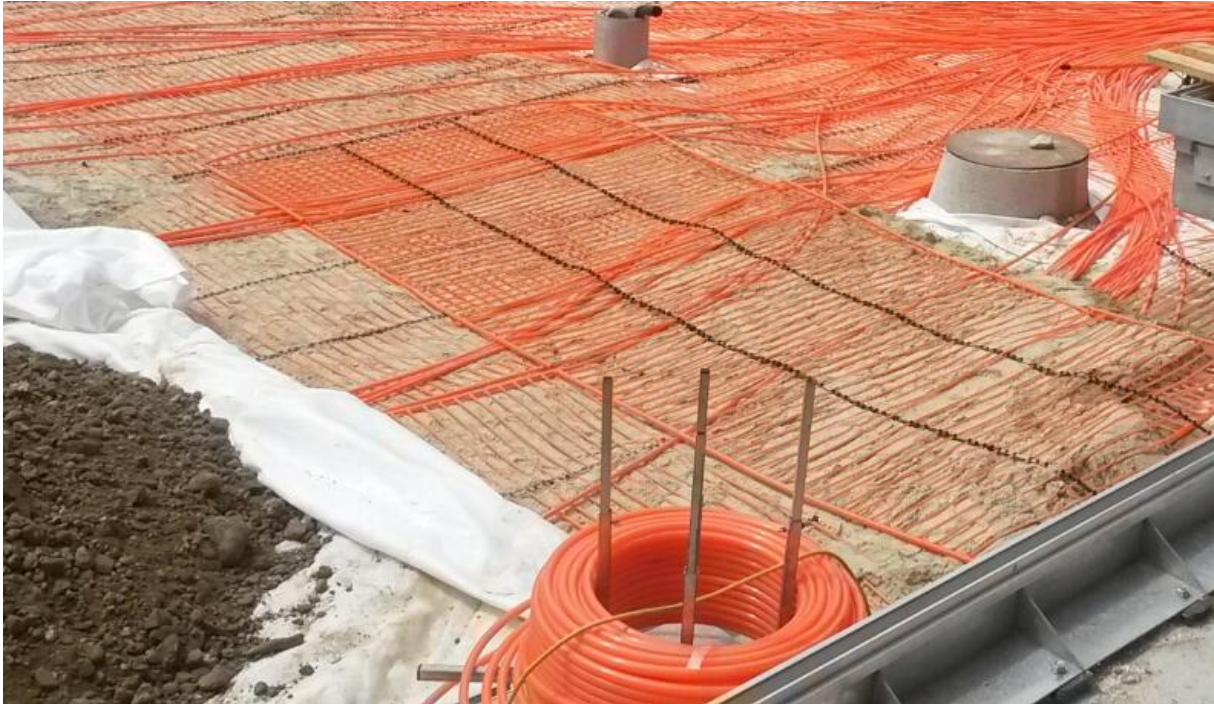
Abbildung 4: Registermatten des Erdspeichers unter dem Parkplatz während der Bauphase. Quelle: Consulting Company Immobilien und Projektmanagement GmbH
