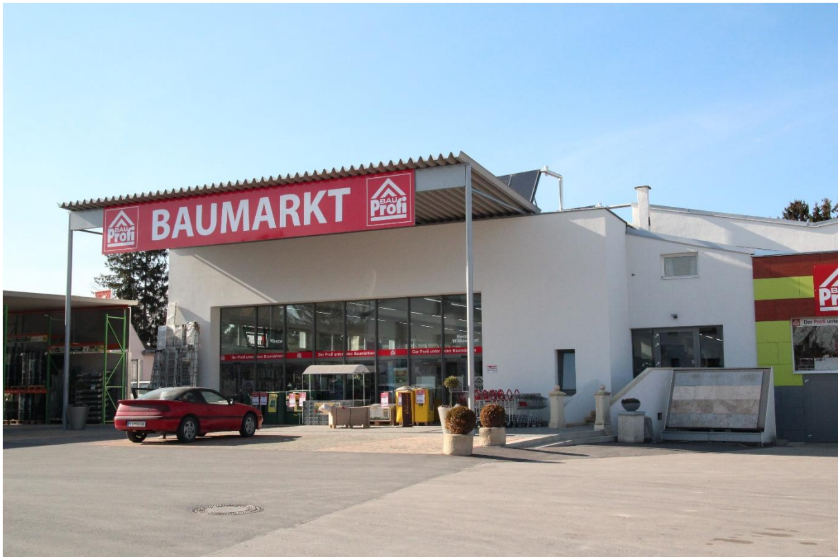
Abbildung 1: Ansicht des Eingangsbereichs (Südostansicht, Quelle: AIT)
