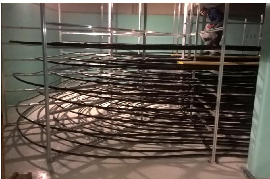
Abbildung 3: Wärmetauscher im Eisspeicher bei Umsetzung der Anlage Audio Tuning Vertriebs GmbH
