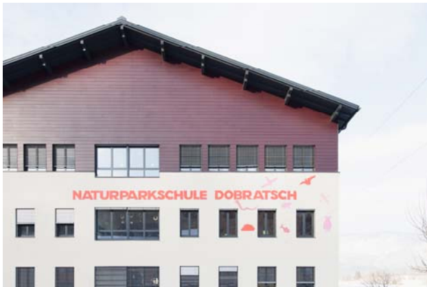
Ansicht süd (nach Sanierung)
