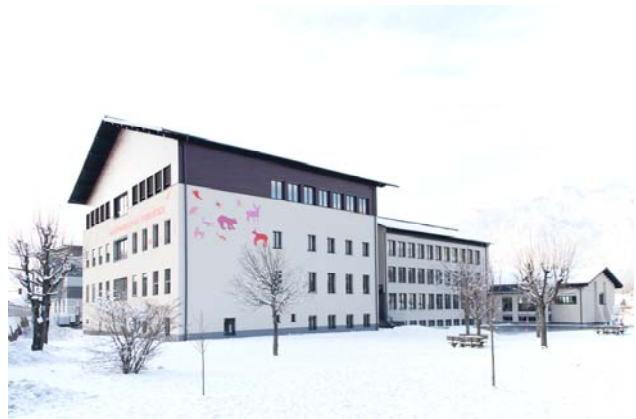
Ansicht süd-Ost (nach Sanierung)
