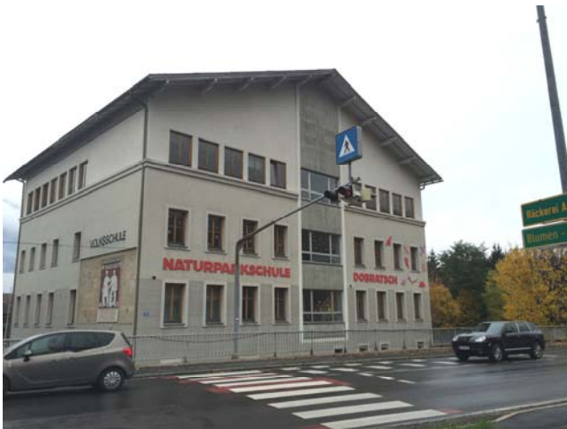
Ansicht süd-west (vor Sanierung)
