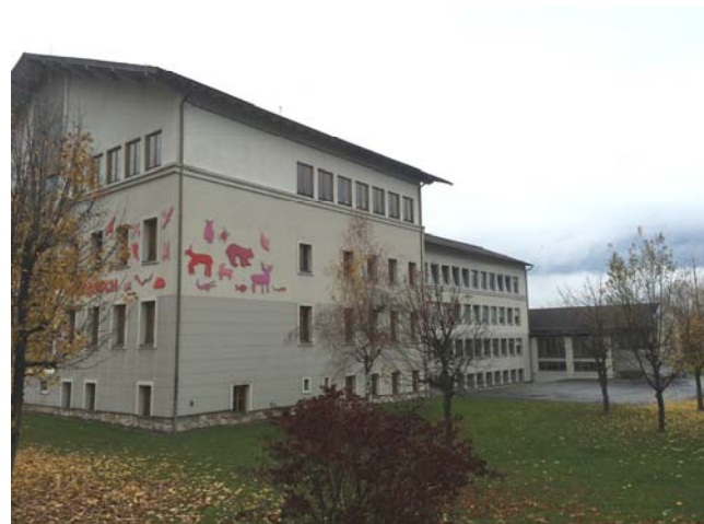
Ansicht süd-ost (vor Sanierung)
