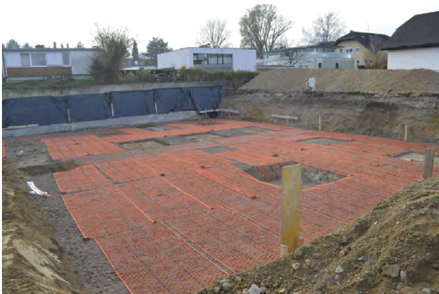
Verlegung des Erdspeichers (1. Lage)
