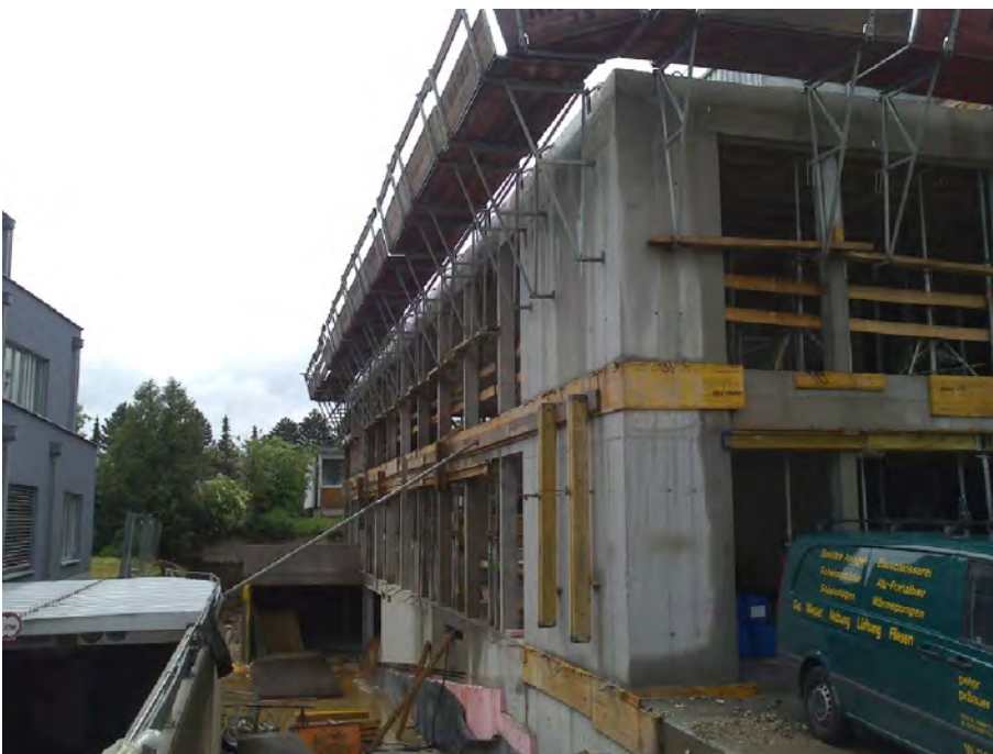
Rohbau in der Fertig- stellungsphase
