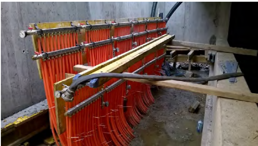
Verteiler Erdspeicher
