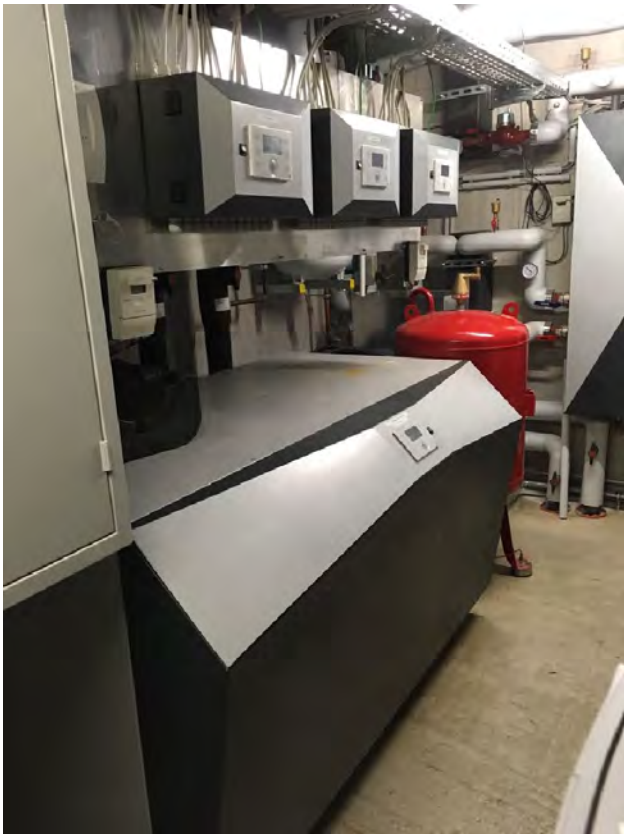
Technikraum mit Wärmepumpe, Regelung und Verteiler
