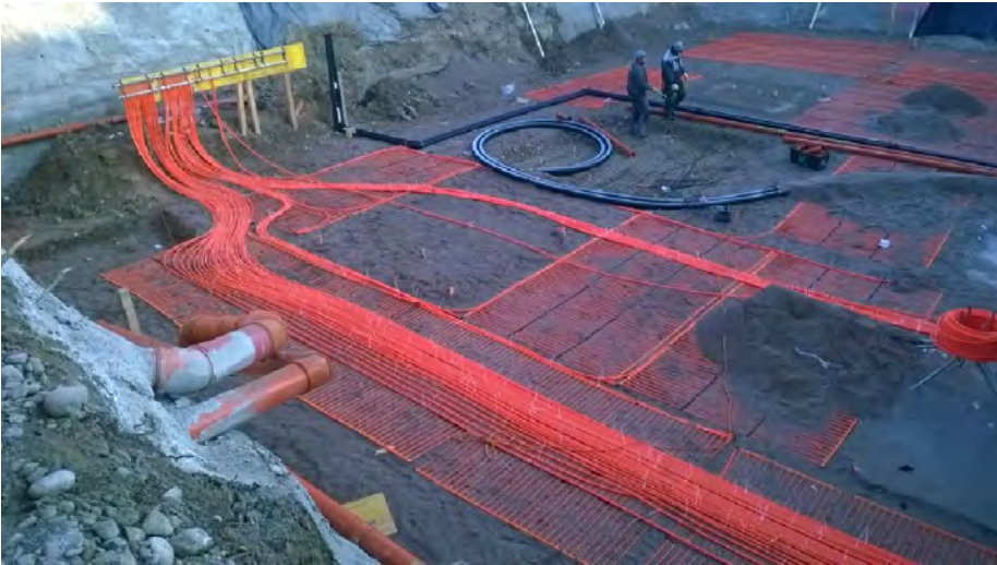
Verlegung des Erdspeichers (2. Lage)
