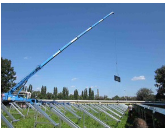
Abbildung 3: Aufstellung der Kollektoren im Herbst (Quelle: SOLID)
