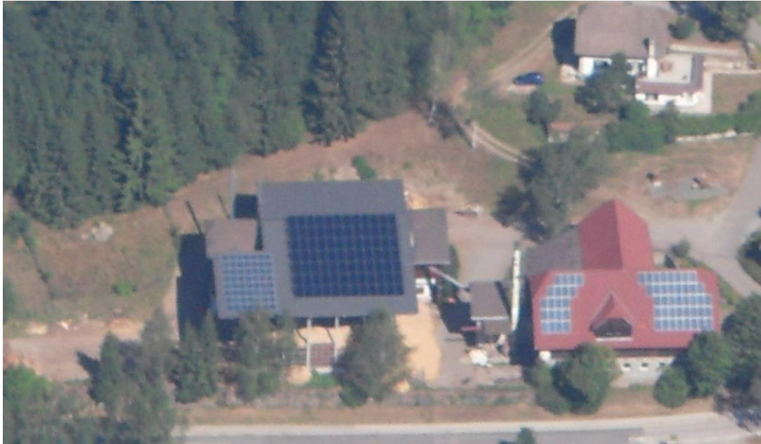
Übersicht Heizwerk Fritzer mit Lagerhalle
