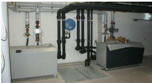
Abbildung 8: Wärmepumpen (linkes Bild); Verteiler und Verrohrung der Rohrregister für den Erdspeicher (rechtes Bild) (Bildquelle: AEE INTEC).
