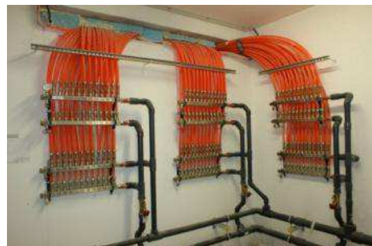
Abbildung 8: Wärmepumpen (linkes Bild); Verteiler und Verrohrung der Rohrregister für den Erdspeicher (rechtes Bild) (Bildquelle: AEE INTEC).
