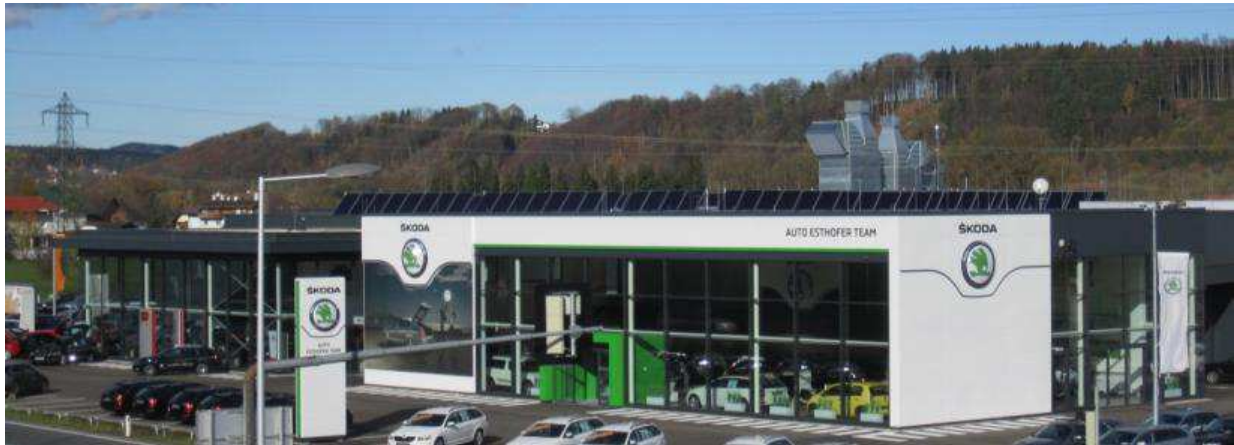
Abbildung 14: Südost-Ansicht des Gebäudes „Autohaus Esthofer“ (Bildquelle: AIT).
