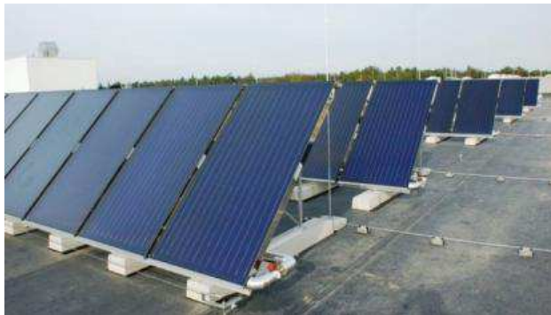
Abbildung 7: Aufständigung der Kollektorreihen am Dach des Büro- und Fertigungsgebäudes (linkes Bild). Pufferspeicher für Heizung und Warmwasserbereitung (rechtes Bild) (Bildquelle: AEE INTEC).
