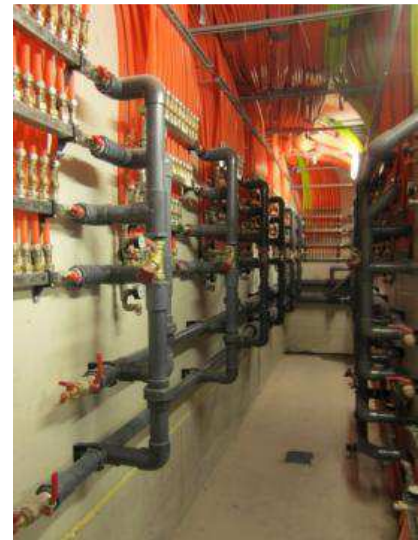
Abbildung 16: Wärmepumpen (linkes Bild); Verteiler und Verrohrung der Rohrregister für den Erdspeicher (rechtes Bild) (Bildquelle: AIT).
