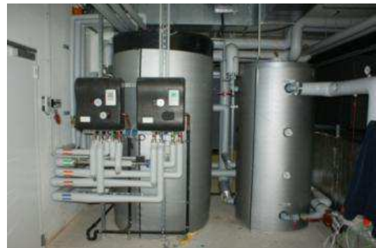
Abbildung 7: Aufständigung der Kollektorreihen am Dach des Büro- und Fertigungsgebäudes (linkes Bild). Pufferspeicher für Heizung und Warmwasserbereitung (rechtes Bild) (Bildquelle: AEE INTEC).
