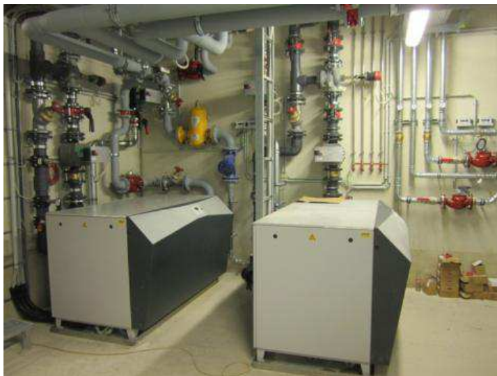
Abbildung 16: Wärmepumpen (linkes Bild); Verteiler und Verrohrung der Rohrregister für den Erdspeicher (rechtes Bild) (Bildquelle: AIT).
