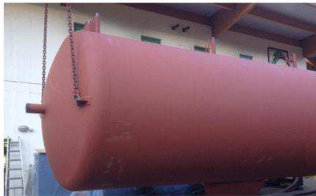
Abbildung 22: Detailaufnahme der Kollektorreihen (links, Bildquelle: Biowärme Mallnitz) sowie des 80 m 3 Pufferspeichers im Zuge der Errichtung (rechts, Bildquelle: Biowärme Mallnitz)
