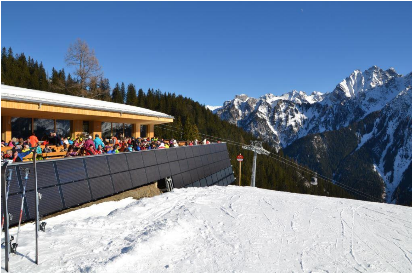
(Abbildung 1: Südansicht des Bergrestaurants „GOONA“, Alpe Palüd, Schigebiet Brandnertal)
