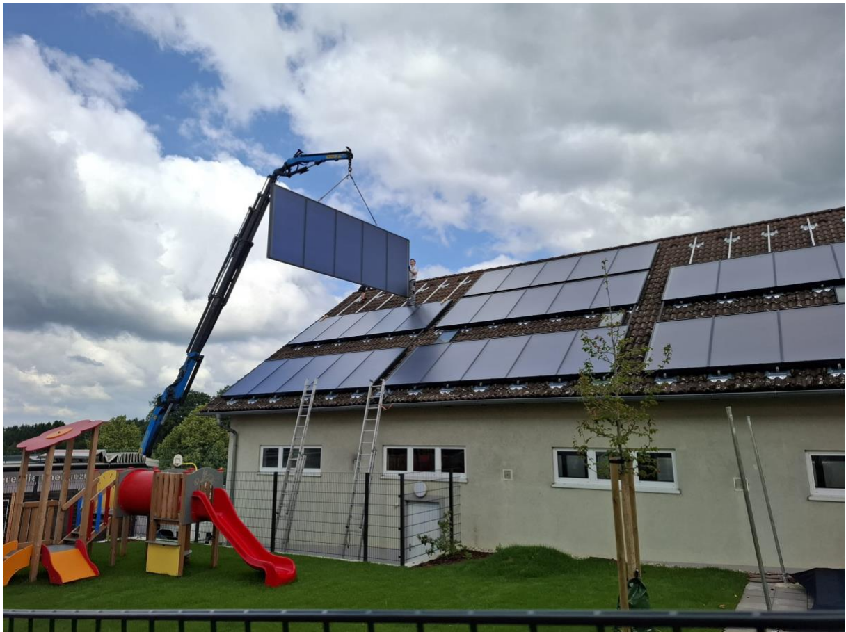
Abbildung 2: Kollektormontage Süd-Ost
