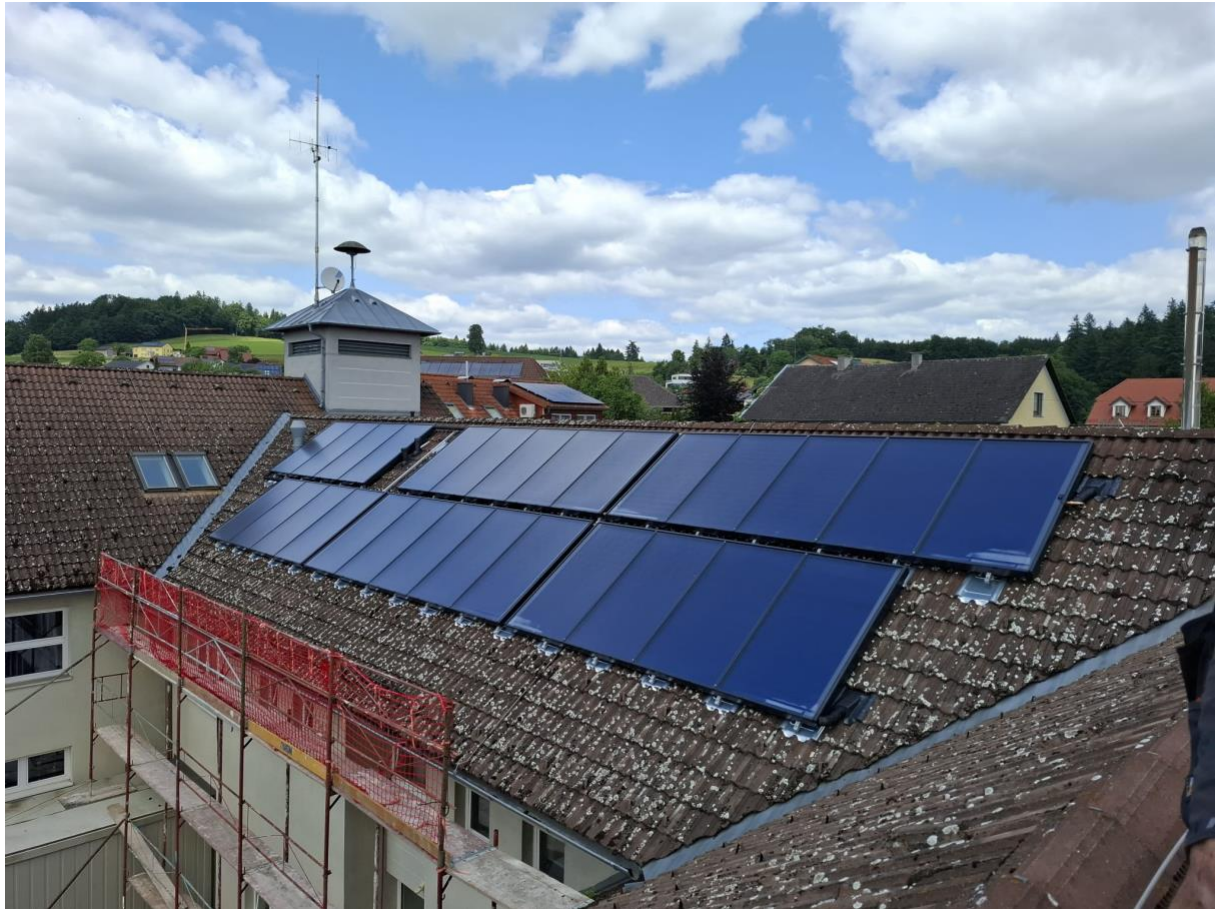
Abbildung 3: Kollektormontage Süd-West
