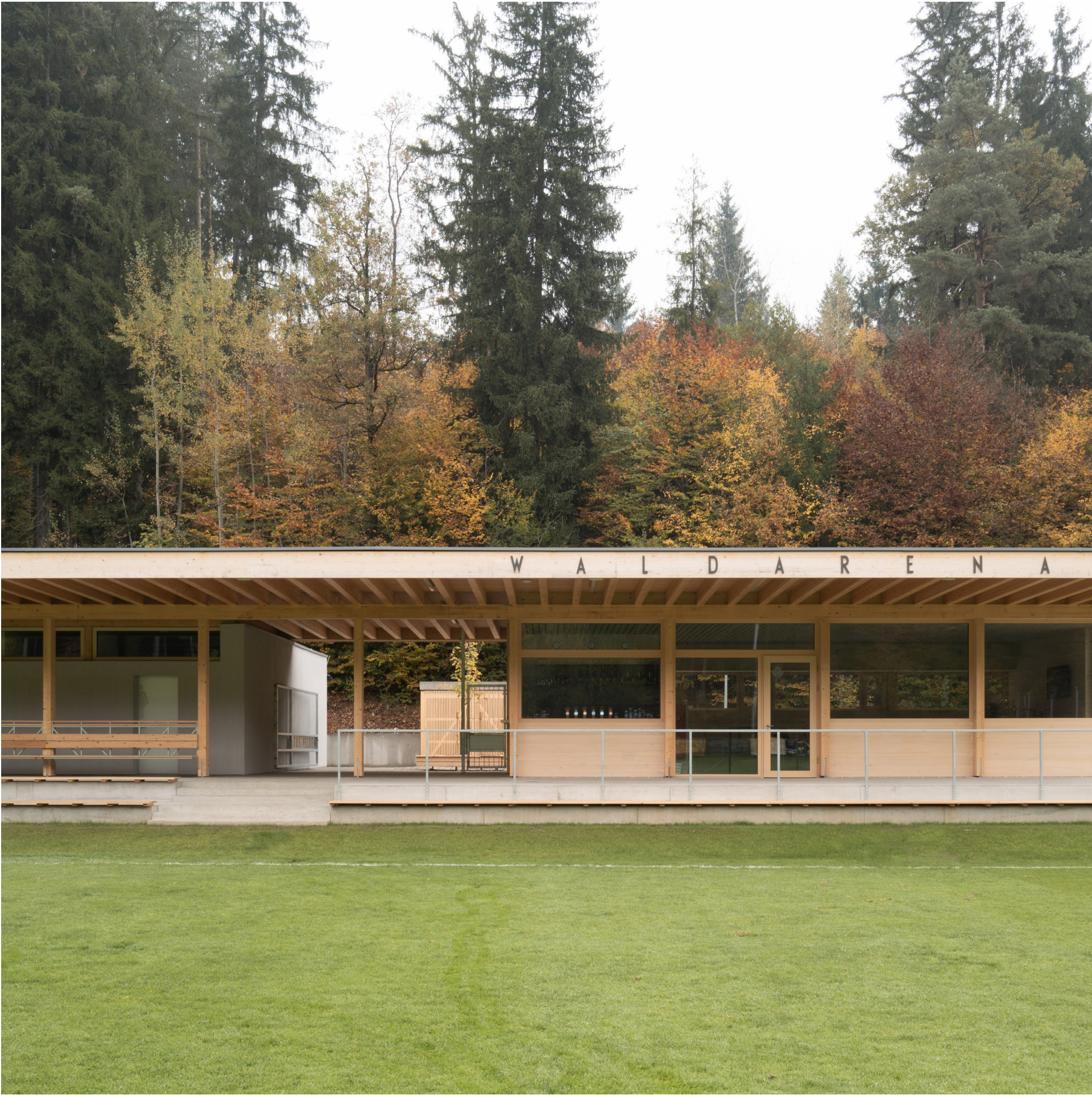
TRIBÜNENDACH hält Bestand und Erweiterung zusammen
