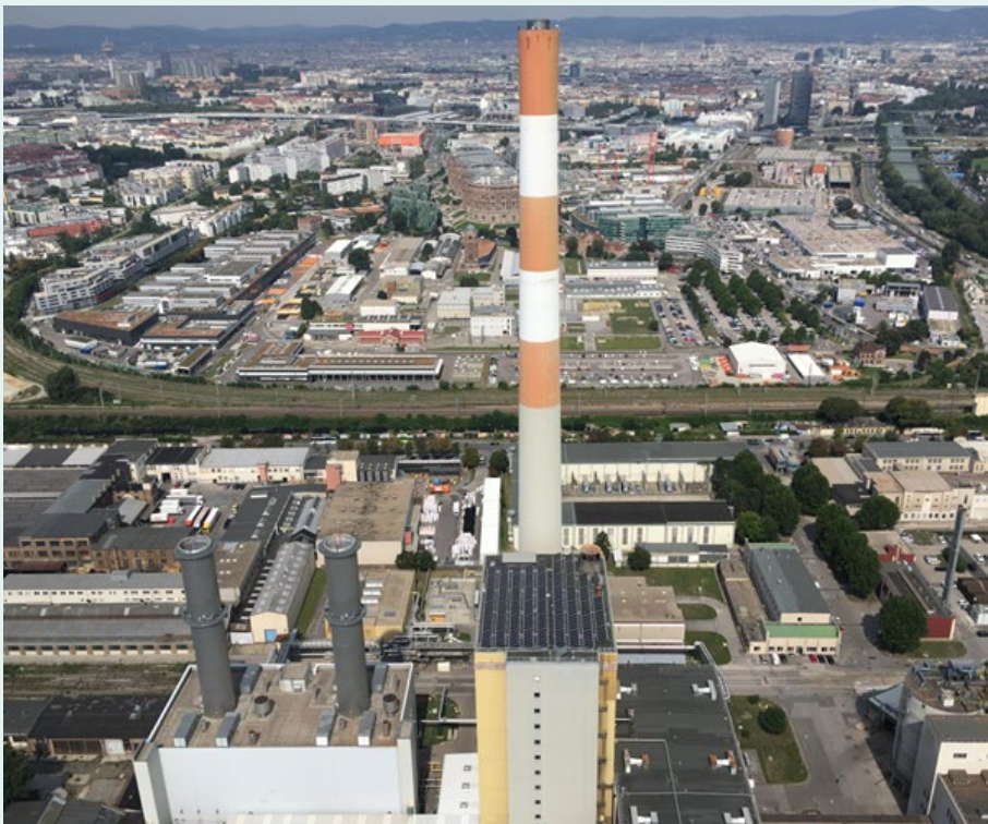
Abbildung 46: Innovative solare Großanlage am Kraftwerk Simmering. (© GREENone-TEC)
