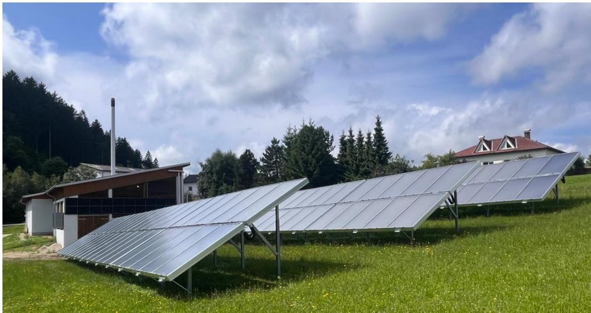
Abbildung 3: Unterkonstruktion 2-reihig für Kollektoren
