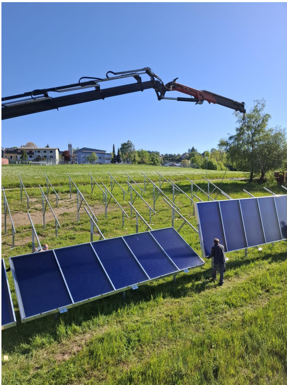
Abbildung 3: Kollektormontage auf Unterkonstruktion
