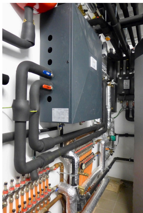
Abbildung 8: Übergabe Erdspeichers in den Technikraum
