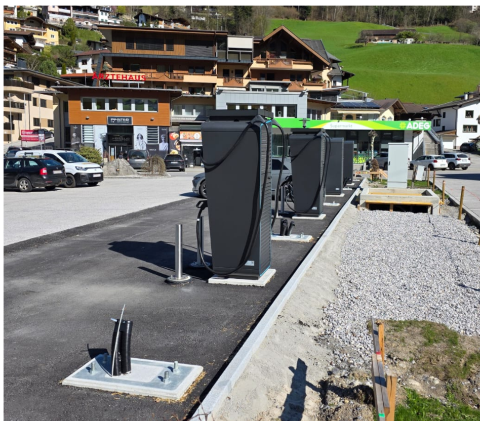
Abbildung 3 Fortschritt April 2025, 2 Bestands Ladestationen (in Betrieb), 2 x 400kW Hypercharger (Inbetriebnahme erst mit Energiecontainer möglich) // Quelle: PTM GmbH
