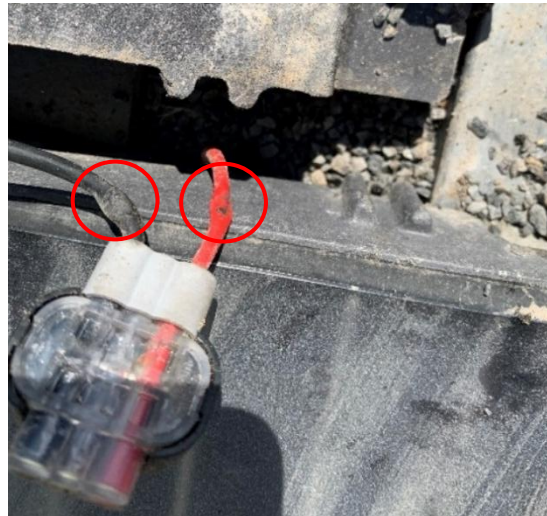
Abbildung 37: gequetschte Stringkabel (09.08.2022) (eigene Darstellung)
