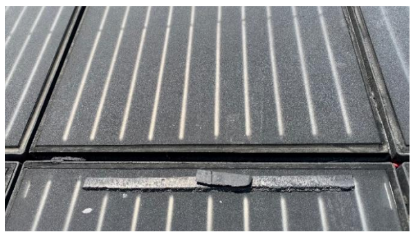
Abbildung 34: Ablösung des Moduls und ausbrechender Rand (22.07.2022) (eigene Darstellung)
