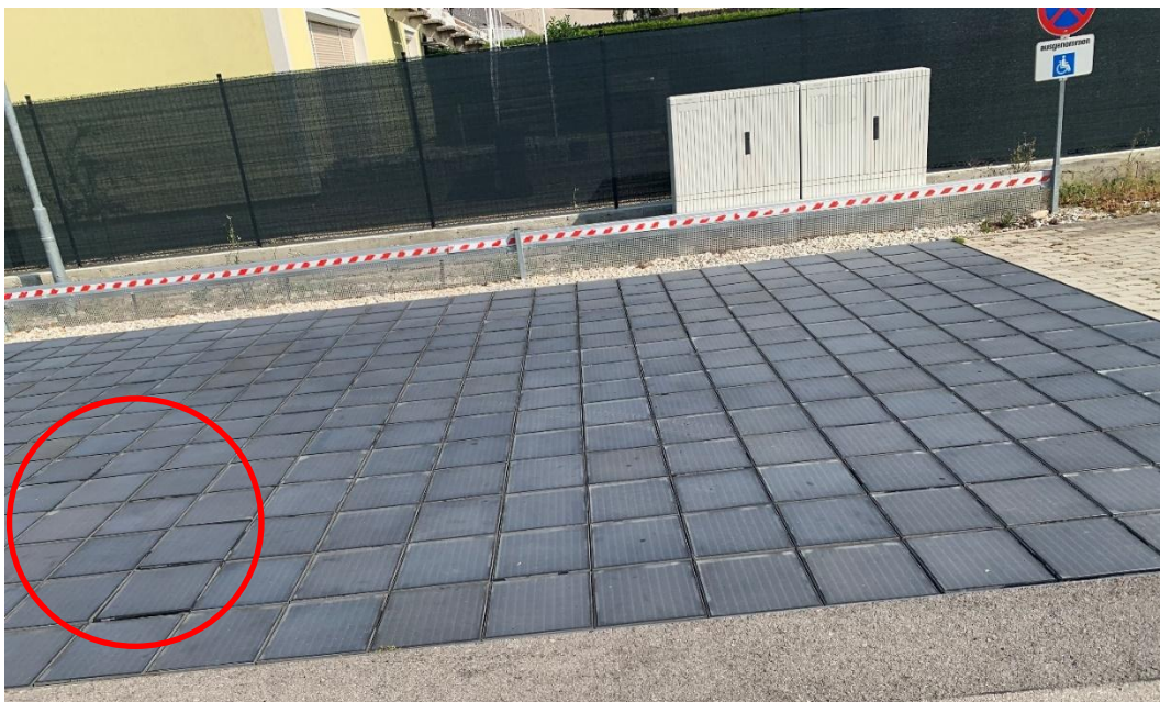
Abbildung 49: vermehrte Anzahl von Modulen mit Delamination und ausbrechenden Modulrändern (in Rot) (eigene Darstellung)
