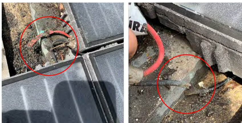
Abbildung 53: Lokalisierte Kabelunterbrechungen im String 2.42 (links) und Strang 2.41 (rechts) mit der Signalübertragungsmethode (eigene Darstellung)
