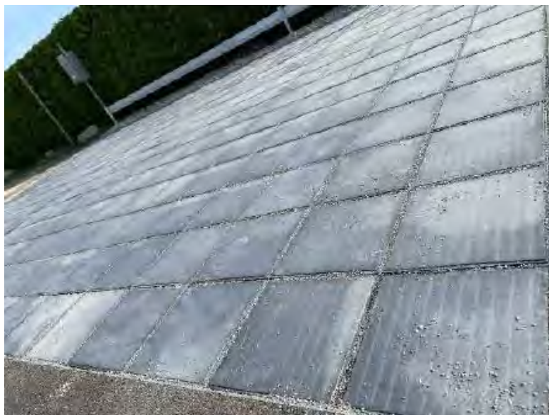
Abbildung 6: Verfüllung der Zwischenräume der PV-Module mit Basaltsplitt (eigene Darstellung)
