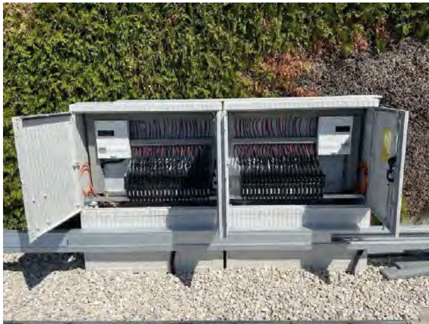
Abbildung 5: Wechselrichterkästen am solaren Parkplatz in Teesdorf (eigene Darstellung)
