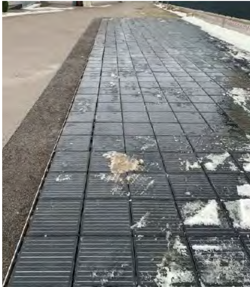
Abbildung 46: größerer Abstände zwischen den Modulen am Anlagenrand (eigene Darstellung)
