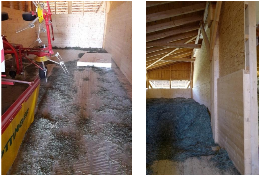
Abbildung 40 Trockenkammer mit Flachrost „Kutschera“ (Quelle FHOÖ und Rudolf Kutschera)
