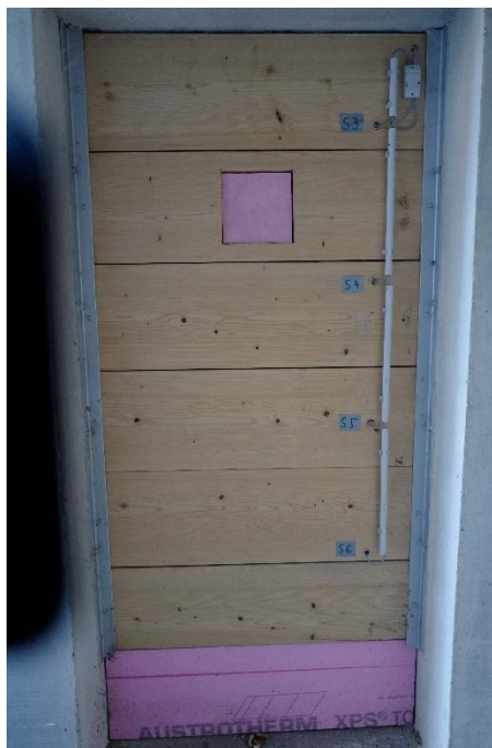
Abbildung 41 Steinspeicher inkl. Temperatursensoren (Quelle: Rudolf Kutschera)
