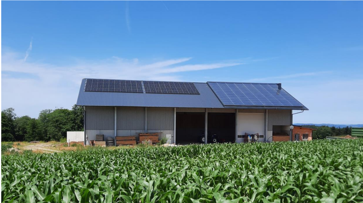
Abbildung 6: Kollektoranlage am Dach der Trocknungshalle (links: Photovoltaik, rechts: Solar-Luftkollektoren) (Quelle: AEE INTEC)
