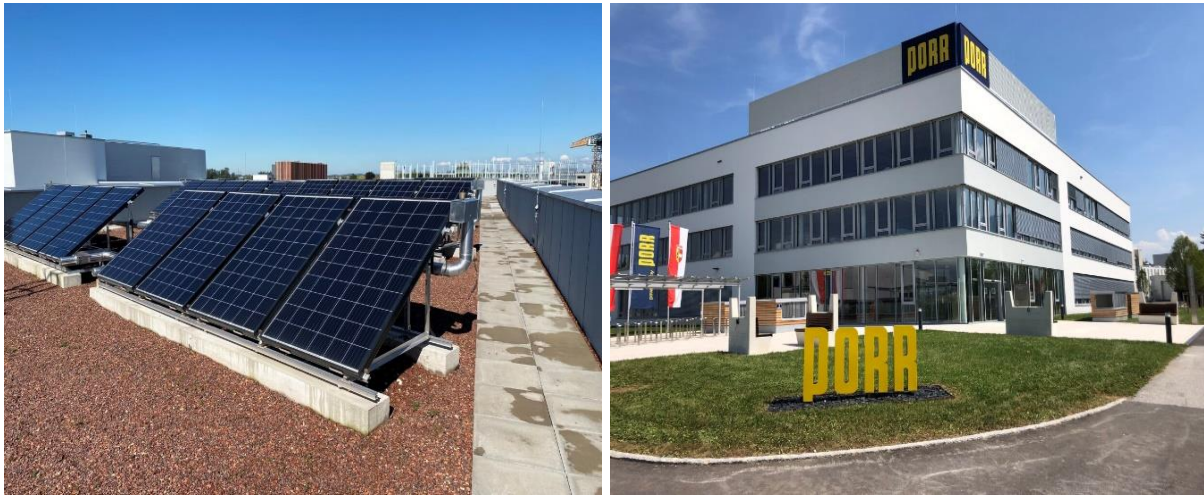
Abbildung 77: Ansicht der am Dach aufgestellten PVT-Kollektoren (links), Bürogebäude der Porr Salzburg (rechts) (Quelle: PORR AG)
