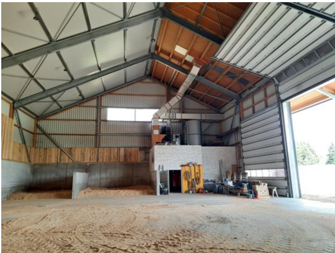
Abbildung 7: Innenraum der Trocknungshalle. Links sind die beiden Trocknungsroste erkennbar, rechts die beiden Solarleitungen vom Dach kommend sowie die Mischkammer (Quelle: AEE INTEC)
