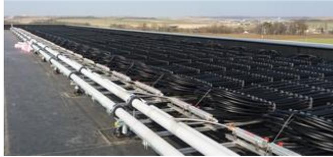
Abbildung 23: Absorbermatten-Bündel (Quelle: Ökoplan Energiedienstleistungen GmbH)
