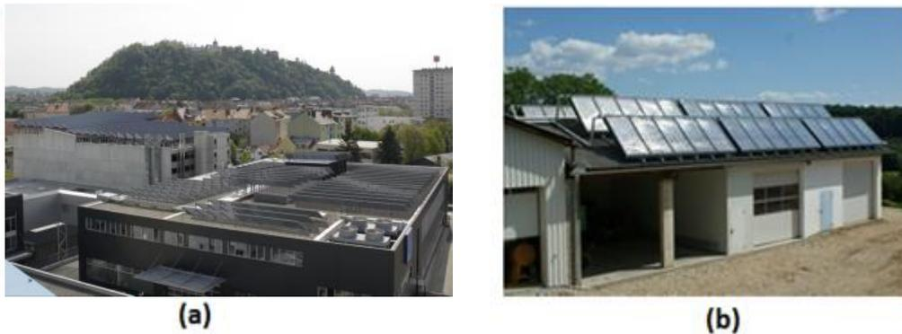
Abbildung 17: (a) AVL, Stmk. (1.879 m<sup>2</sup>, 70m<sup>3</sup>, SD<sub>kälte</sub>: 6%, SE: 321 bzw. 395 kWh/m<sup>2</sup>a; SPF<sub>th.</sub>: 0,75). (b) Obstsaftproduktion Krispel (100 m<sup>2</sup>, 20m<sup>3</sup> Wasserspeicher, SD: 30%, SE: 374 kWh/m<sup>2</sup>a SPF<sub>el.</sub>: 3,5; SPF<sub>th.</sub>: 0,4); alle Bildquellen: AEE INTEC
