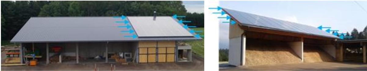
Abbildung 47: Dachintegration der Luftkollektoranlagen (Bildquellen: Bauherren)
