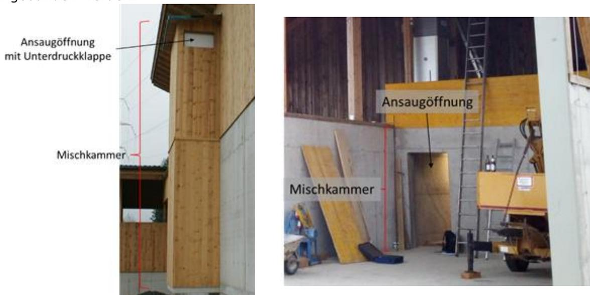
Abbildung 48: Mischkammern und Ansaugöffnungen (Bildquellen: AEE INTEC)
