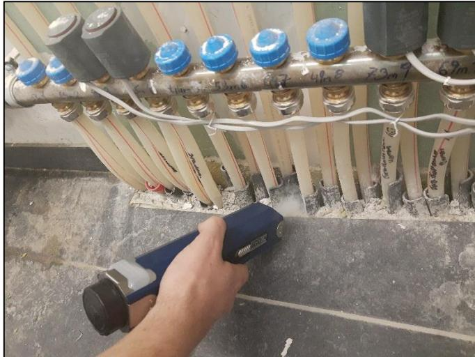
2. Undichtheiten durch die offene Durchführung der Heizleitungen der Fußbodenheizung im Technikraum (HKLS).
