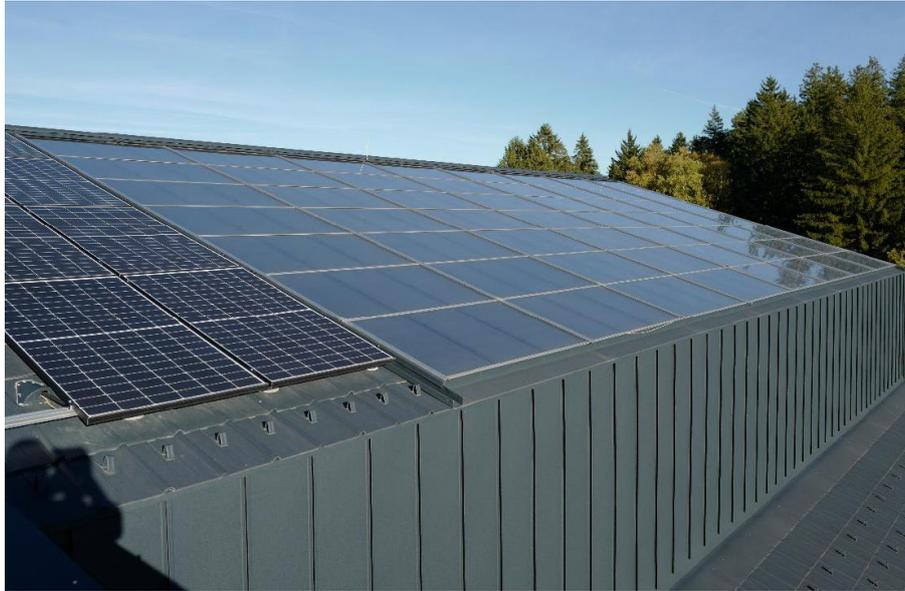
Abbildung 5: Südwestliches Luftkollektorfeld mit insgesamt 114,5 m<sup>2</sup> Kollektorfläche und ein Teil der 17 kWp PV- Anlage am Ziegenstall (Quelle: Rudolf Kutschera)
