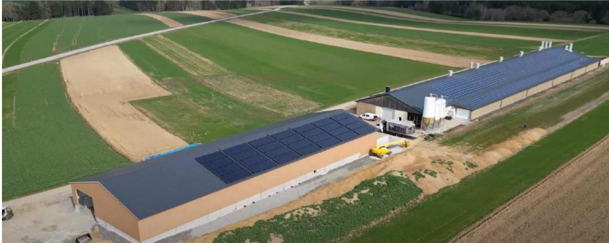
Abbildung 7: im Vordergrund Lagerhalle mit 336 m<sup>2</sup> Kollektorfeld und im Hintergrund die Masthalle mit einer 200 kWp PV- Anlage (Quelle: Roland Bauer)
